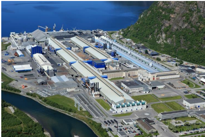
Hydro Sunndal. Foto: Norsk Hydro ASA
