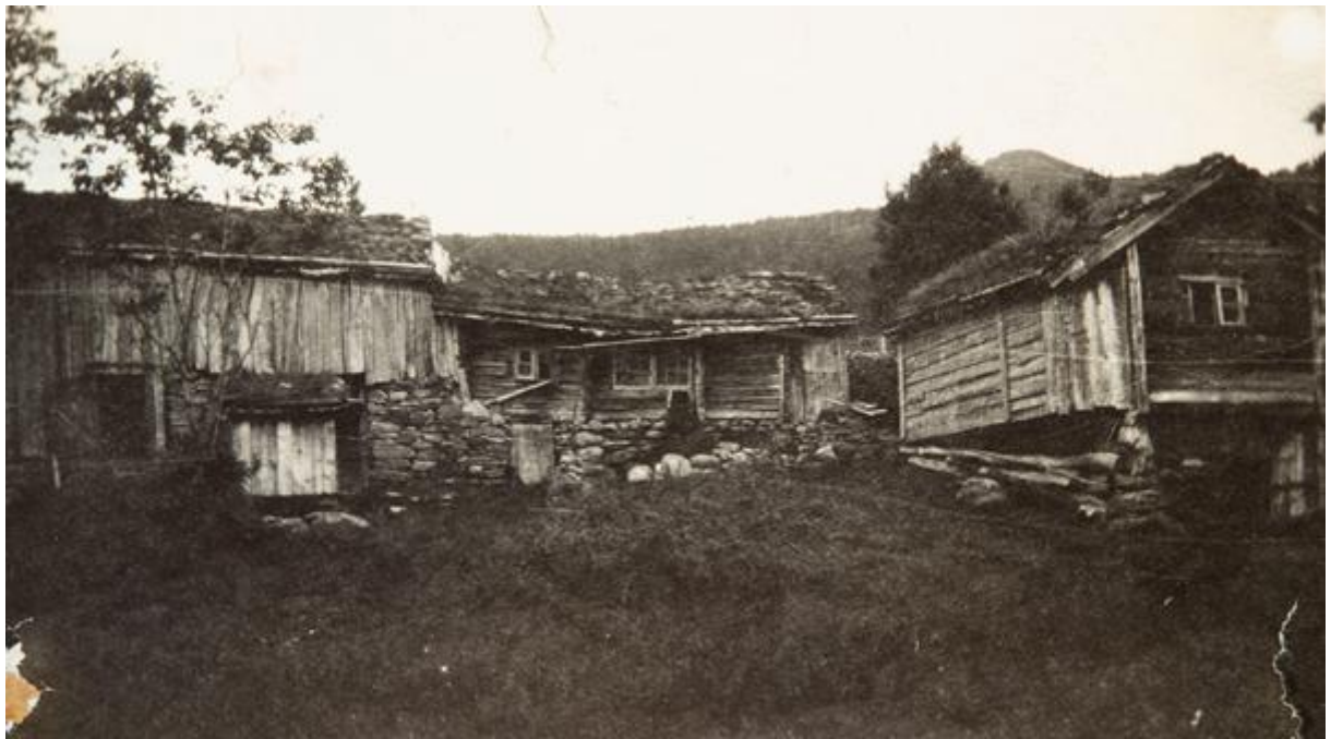
Bilde av garden Gjerdet i Ørskog - til bruk i saksbehandling i bygningsvern. Foto: Ukjend / Eigar: Magnhild Bakke
